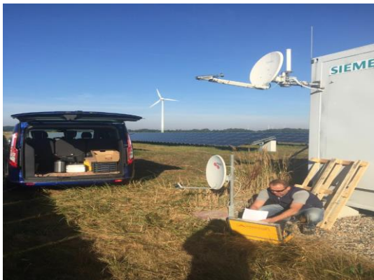
Abbildung 35: Prozess des Austauschs und Justierung der Satellitenschüsseln [9]
