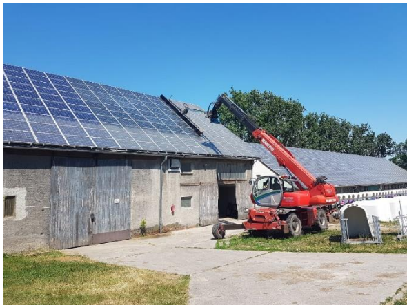
Abb. 41: Module, die eine Reinigung brauchen [9]
