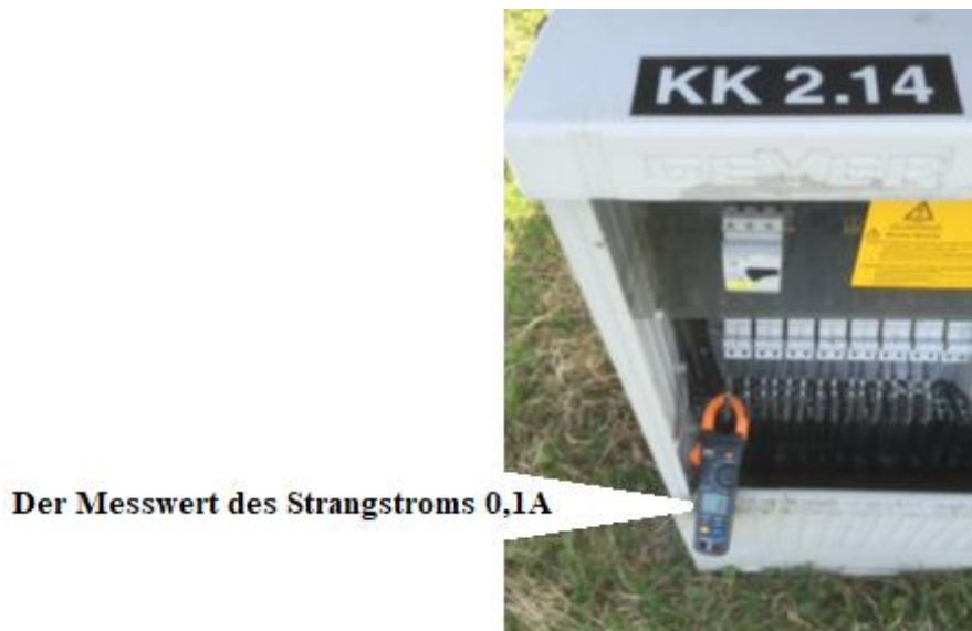
Abbildung 31: Defekte Strangsicherung mit Messwert 0,1 A [9]
