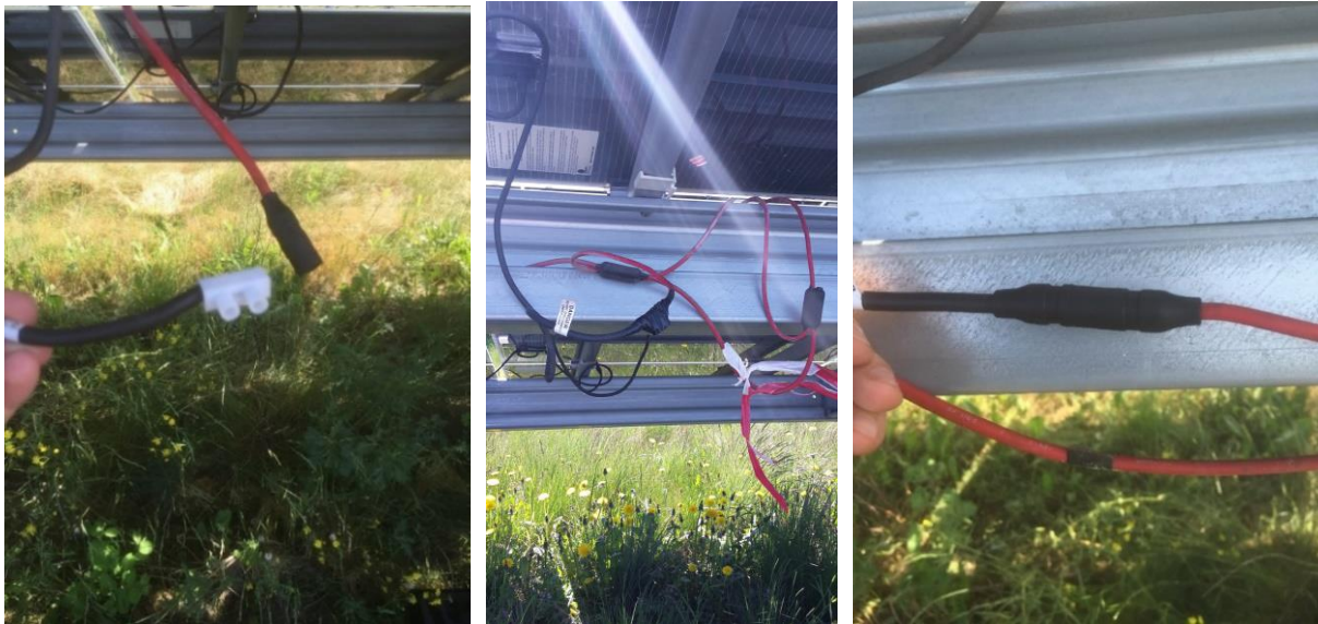
Abbildung 34: Prozess des Austauschs der Y-Verbinder und MC4 [9]
