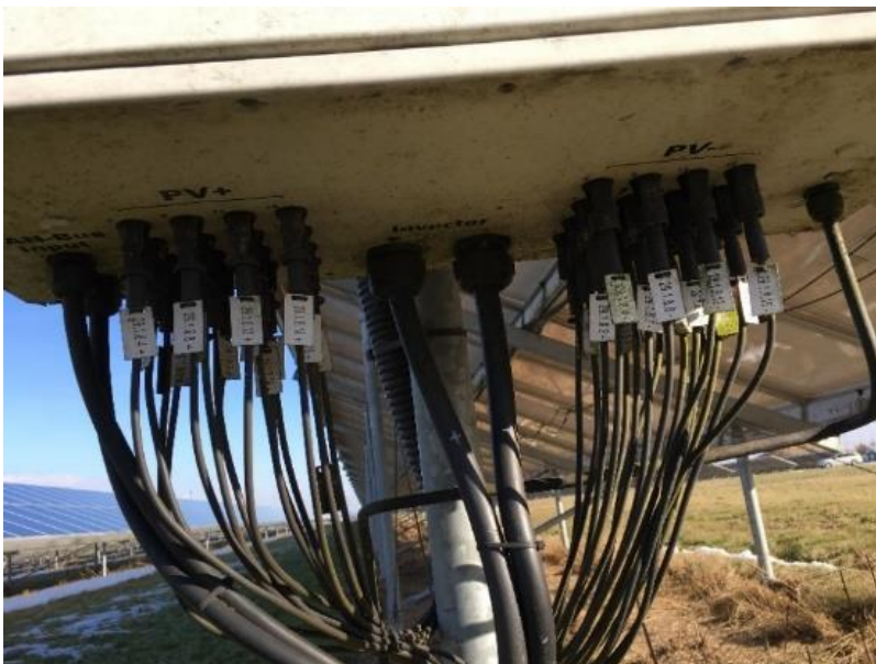
Abbildung 33: Kabeleinführungen in den GAK von den Modulen und zum WR [9]
