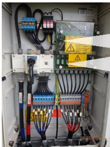
Abbildung 30: Platine und Strangicherung im Generatoranschlusskasten [9]
