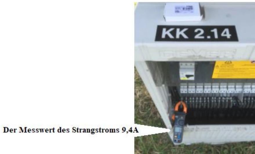
Abbildung 32: Ausgetauschte Strangsicherung mit Messwert 9,4 A [9]
