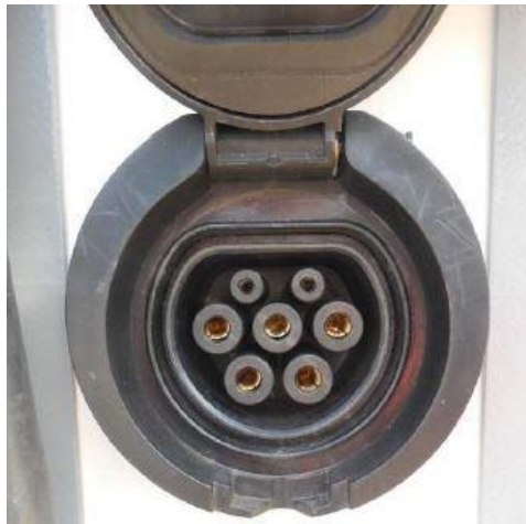
Abbildung 2.17: Typ 2 Steckdose an Ladestation Abbildung 2.18: Belegungen der Typ 2 Steckdose
