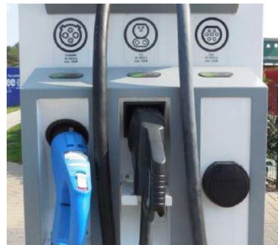
Abbildung 2.16: DC-Ladestation Stecker Quelle: (vgl. Koeppen. (2019))
