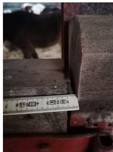
Abbildung 11: Quetsch- und Scherstelle Tür
