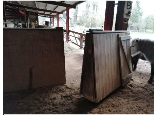
Abbildung 16: Reithallentür schlägt nach innen auf
