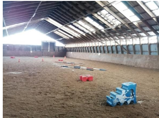
Abbildung 9: Reithalle auf dem Reitbetrieb I bei der Besichtigung
