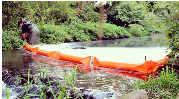
Abbildung 4: Ölsperre im Einsatz bei einer Gewässerverunreinigung [iii]
