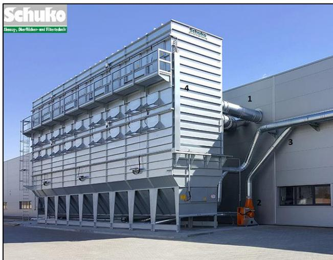
Abb. 5: Industrielle Filteranlage [18]
