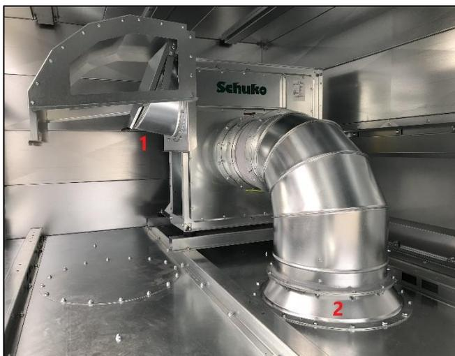
Abb. 36: Ein- und Ausströmen am Ventilator bei Unterdruckanlagen [22]
