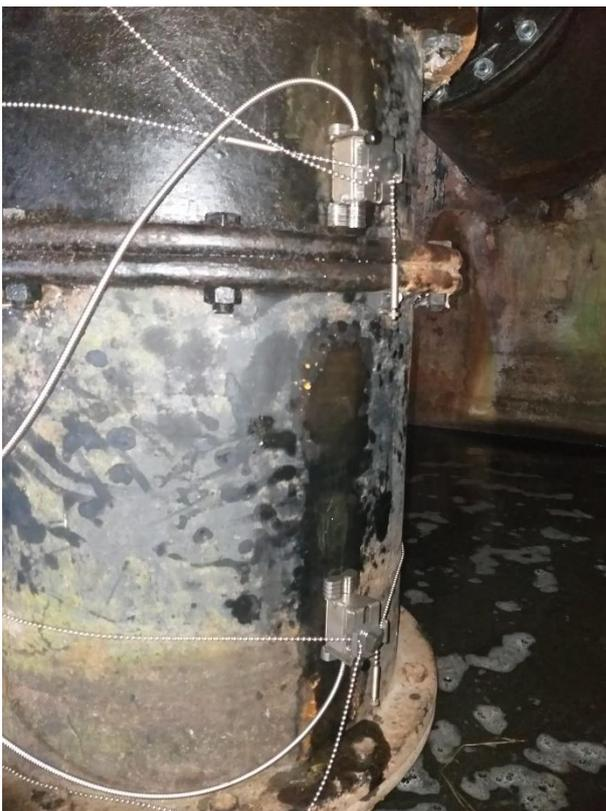
Abbildung 9: Messanordnung des Ultraschallmessgerätes am Steigrohr
