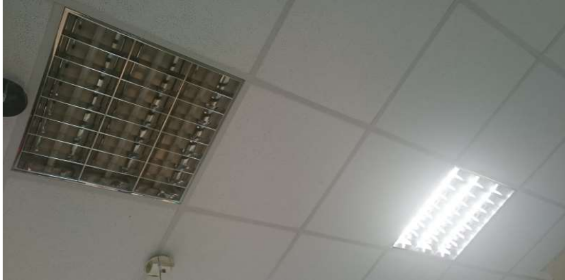
Abb. 17: Nicht funktionsfähige Deckenleuchte. Quelle: Eigene Darstellung.
