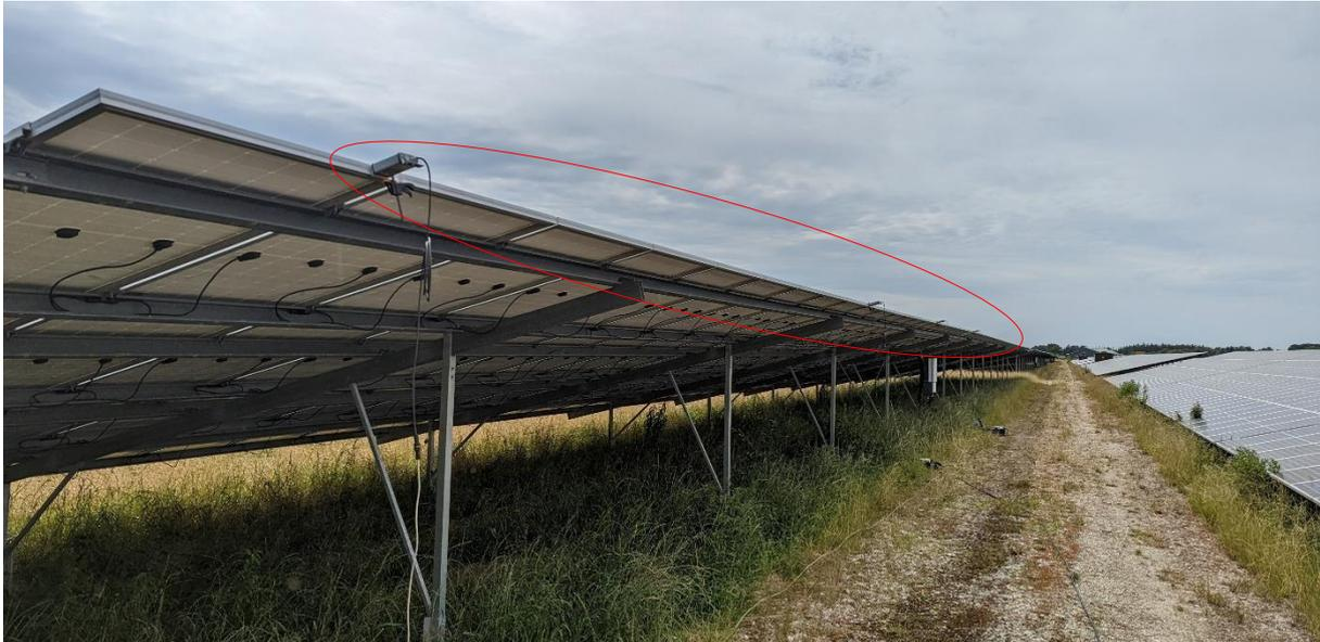
Abbildung 31: Vier Einstrahlungssensoren befestigt an dem oberen Modul Strang, (rot markiert)
