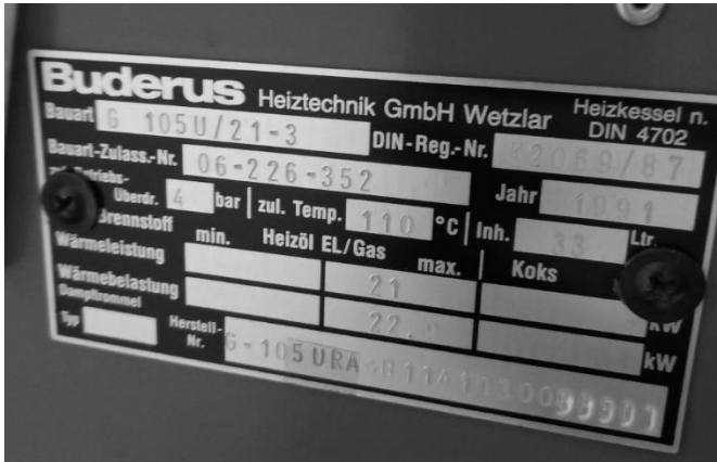
Anhang Abbildung 5: Typschild Heizkessel (Unterlagen des Kunden)
