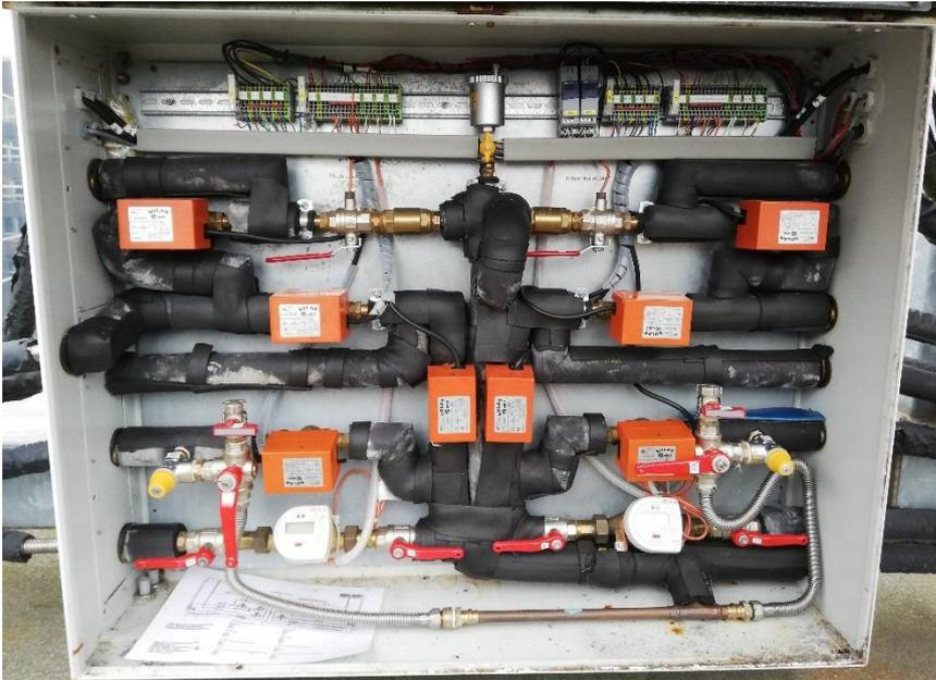
Abbildung 3.2 – Absperrventile im Schaltschrank auf dem Dach des ZET
