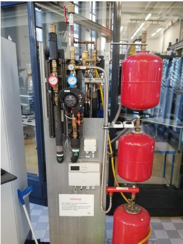
Abbildung 3.3 – Umwälzpumpe, Drosselventile und Ausdehnungsgefäße
