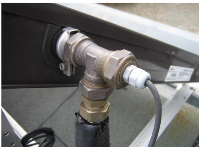
Abbildung 3.5 – Tauchfühler am Kollektoranschlussstutzen eines Flachkollektors
