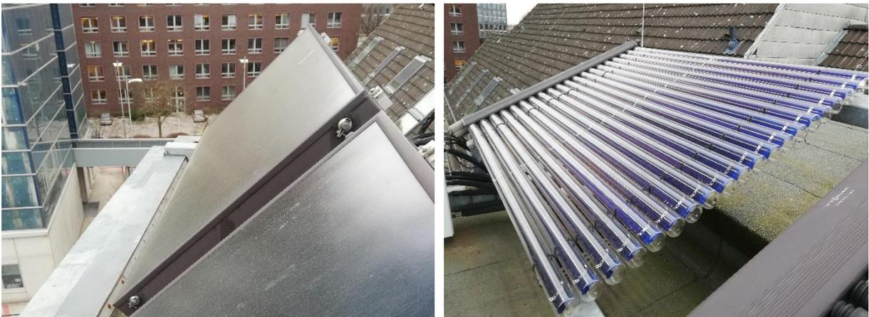
Abbildung 3.1 – Links: Flachkollektor, rechts: Vakuumröhrenkollektor
