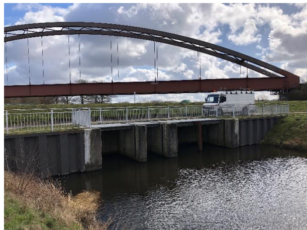
Abbildung 12: Auslaufbauwerk des Neetzekanaldükers (Brößler, eigene Aufnahme, 2023)
