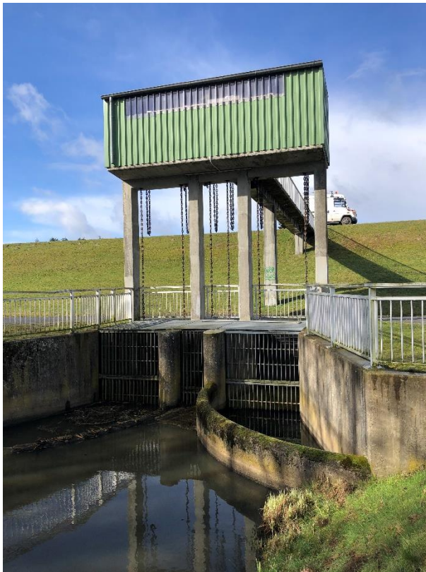
Abbildung 15: Einlaufbauwerk des Schnedegrabendükers (Brößler, eigene Aufnahme, 2023)
