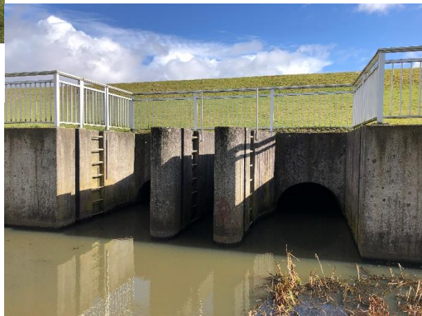
Abbildung 16: Auslaufbauwerk des Schnedegrabendükers (Brößler, eigene Aufnahme, 2023)
