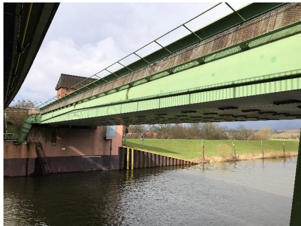
Abbildung 18: Hochwassersperrtor Artlenburg (Brößler, eigene Aufnahme, 2023)
