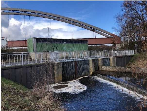
Abbildung 11: Einlaufbauwerk des Neetzekanaldükers (Brößler, eigene Aufnahme, 2023)
