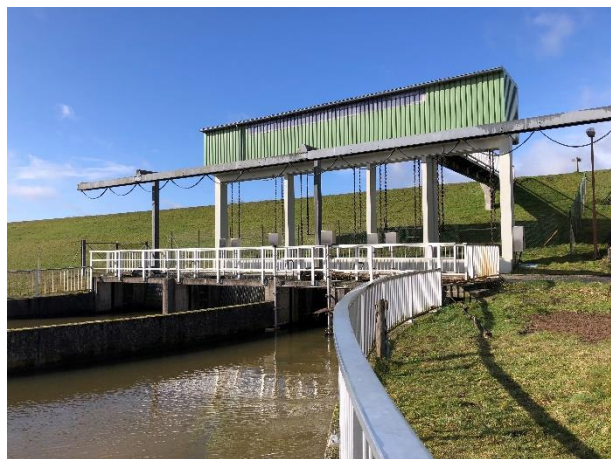
Abbildung 13: Einlaufbauwerk des Neetzedükers (Brößler, eigene Aufnahme, 2023)
