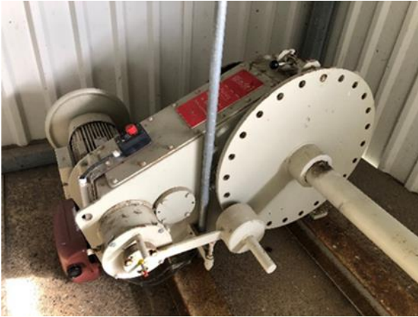
Abbildung 4: Winde im Drosselschützsteuerstand des Netzedükers (Brößler, eigene Aufnahme, 2023)
