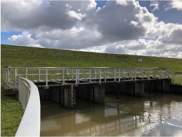
Abbildung 14: Auslaufbauwerk des Neetzedükers (Brößler, eigene Aufnahme, 2023)
