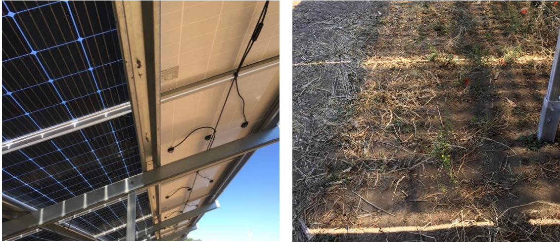
Abbildung 5: Vergleich zwischen bifazialen und monofazialen Modulen auf der Modulunterseite (links) und des auf den Boden aufkommenden Lichtes (rechts) (Enerparc AG)
