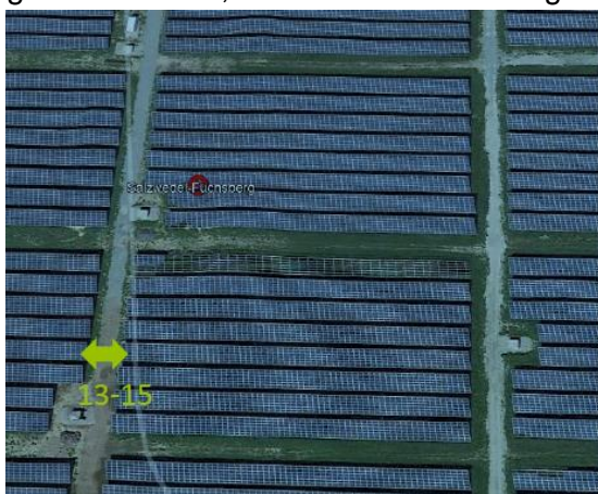
Abbildung 19: Satellitenbild einer Freiflächen-Photovoltaikanlage der Enerparc AG (Enerparc AG)
