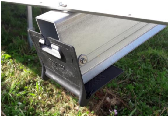
Abbildung 17: Modulunterkantenschutz; Quelle: Enerparc AG
