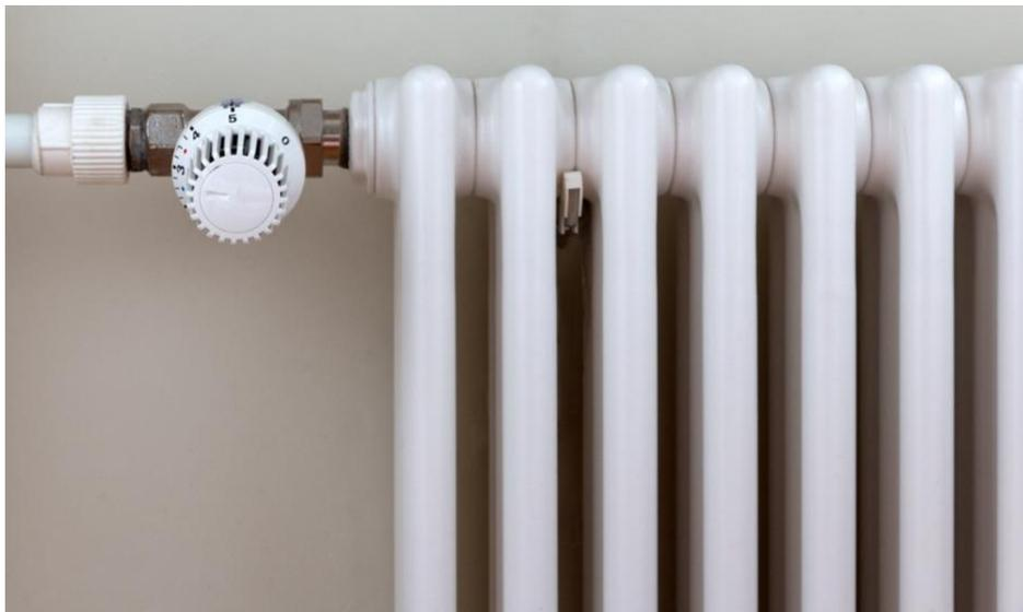
Abbildung 18: Stahlröhrenheizkörper [23]
