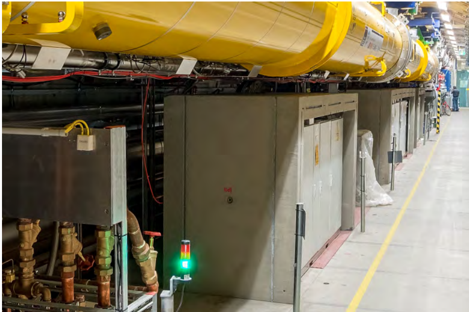
Abbildung 2.1: Position der Schaltschränke im Tunnel [18]
