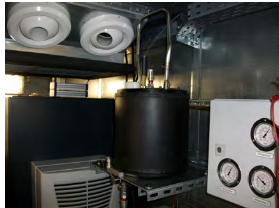
Abbildung 3.3: Behälter nach Umbau (1/3)
