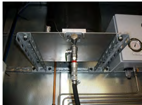
Abbildung 3.5: Behälter nach Umbau (3/3)
