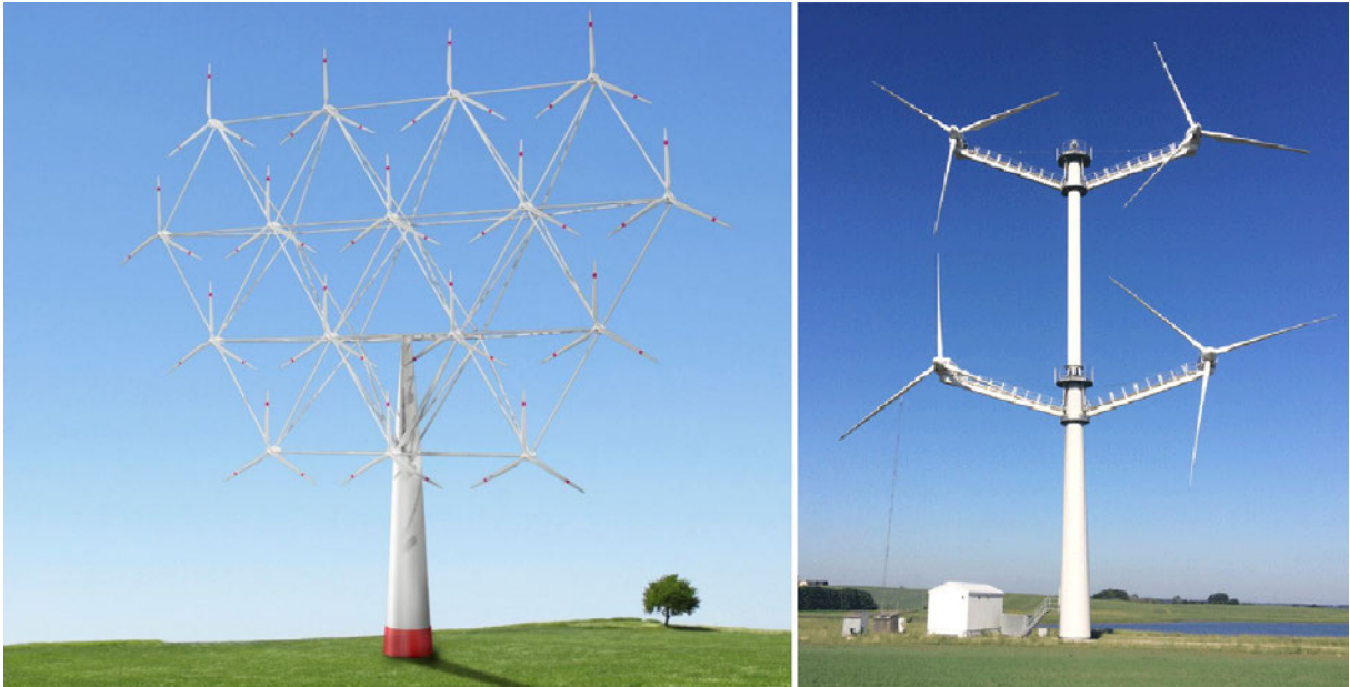
Abbildung 2.1: Beispiele für MRWEA: 5 MW-Entwurf (links); Vestas Miltirotor mit 900 kW (rechts) (In Anlehnung an [29, 61])
