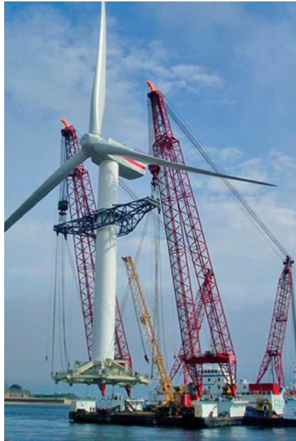
Abbildung 3.3: Transport und Aufbau einer vormontierten Windenergieanlage [47]
