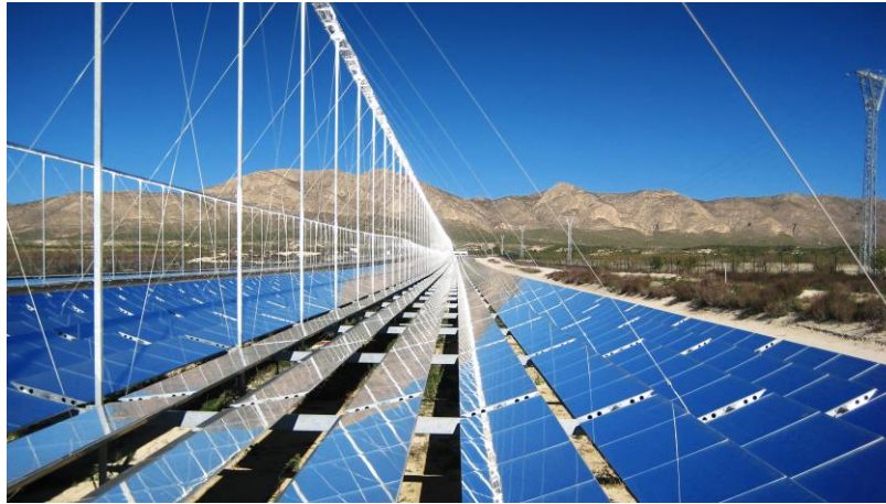
Abbildung 15: Beispiel eines Fresnel-Kollektors [19]
