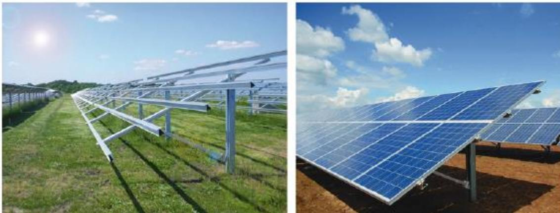
Abbildung 14: Beispielhaftes Montagegestell einer Freiflächenanlage
