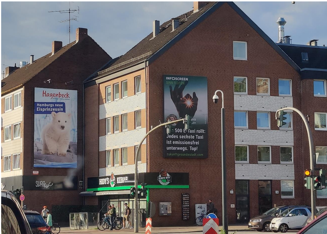
Abbildung 18: Link: OOH; Rechts: DOOH / an einer großen Straßenkreuzung in Hamburg 31
