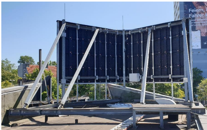
Abbildung 61: Stahlkonstruktion zur Montage einer LED-Wand auf einem Dach 102
