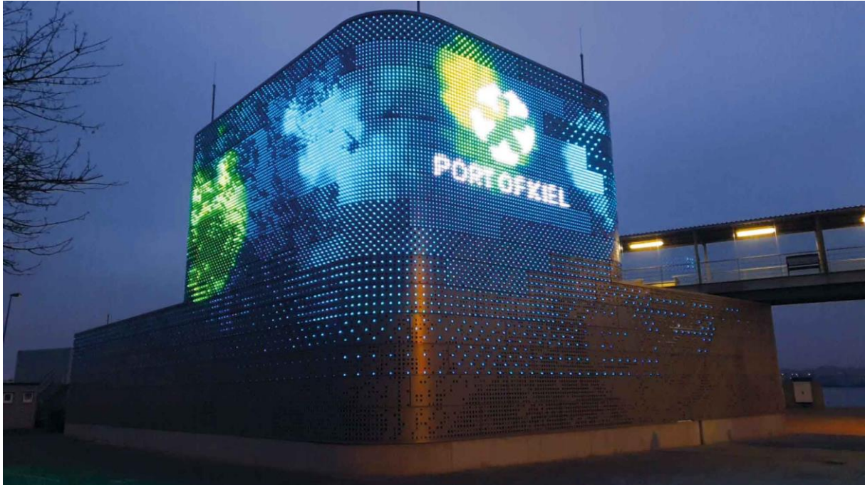
Abbildung 20: Port of Kiel - LED Fassade der Landstromanlage am Ostseekai 35
