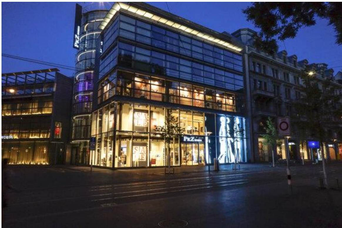
Abbildung 42: Fassadenintegrierte Videoinstallation eines Shops in Zürich 75
