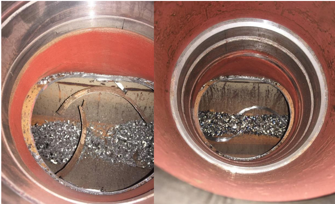
Abbildung 1 Bohrspan durch Anbohrverfahren
