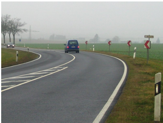
Abbildung 5.3: Beispiel einer Bundesstraße nach Quick-OSM [14]
