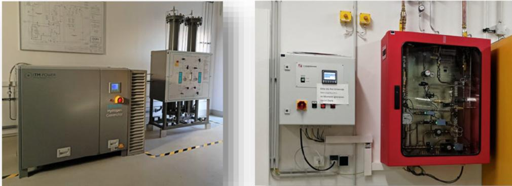
Abbildung 12: Bild des Elektrolyseurs (links) und des Gasmischers (rechts) am TEC
