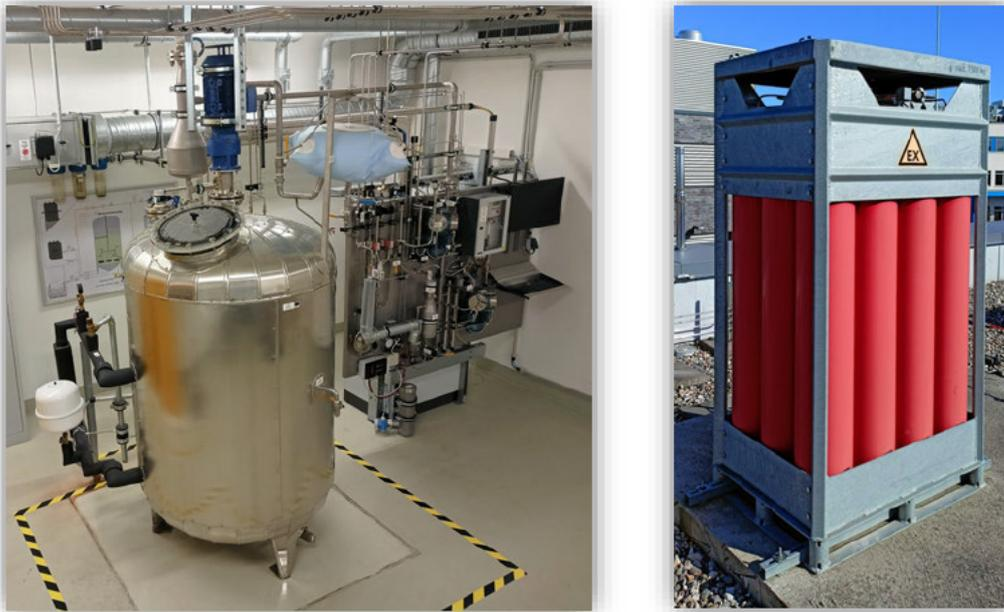
Abbildung 11: Bilder der Methanisierung und des Wasserstoffspeichers am TEC
