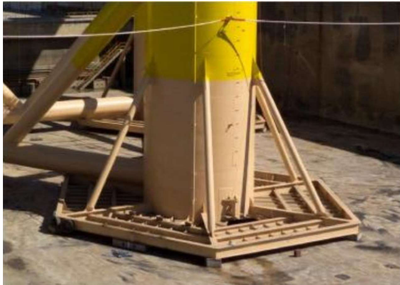
Abbildung 25: Heaveplate am unteren Ende einer Ballastsäule [28]
