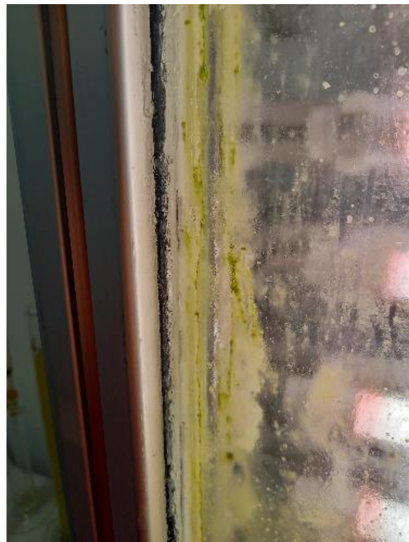
Abbildung 36: Biofouling in und um den Luftzufuhrschlauch (links), Biofouling an Scheiben und Silikonfugen (rechts)
