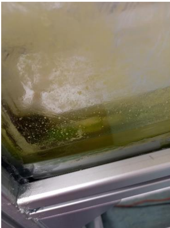
Abbildung 36: Biofouling in und um den Luftzufuhrschlauch (links), Biofouling an Scheiben und Silikonfugen (rechts)
