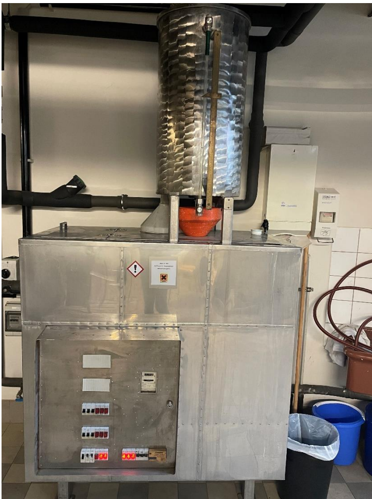
Abbildung 9 Kaltwasserbecken und Füllbehälter mit Füllstandsanzeige
