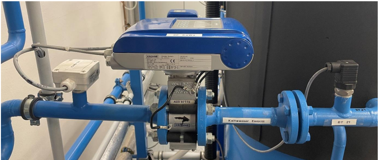
Abbildung 11 Durchflussmessgerät Kaltwassereintritt
