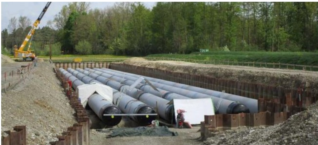
Abbildung 2.12: Röhrenspeicher [107]
