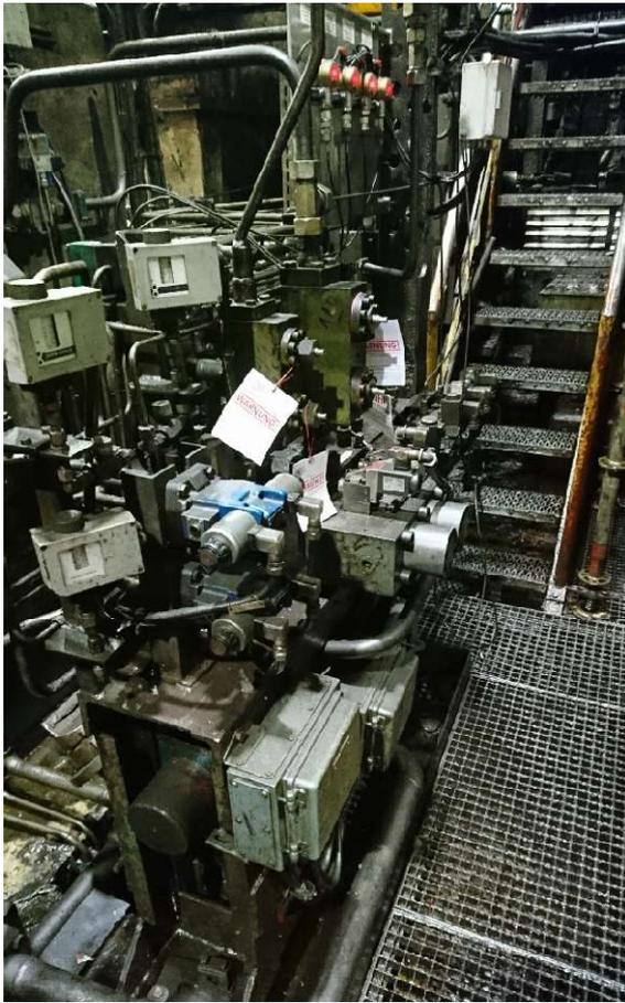
Abbildung 5 - Ventilstand
