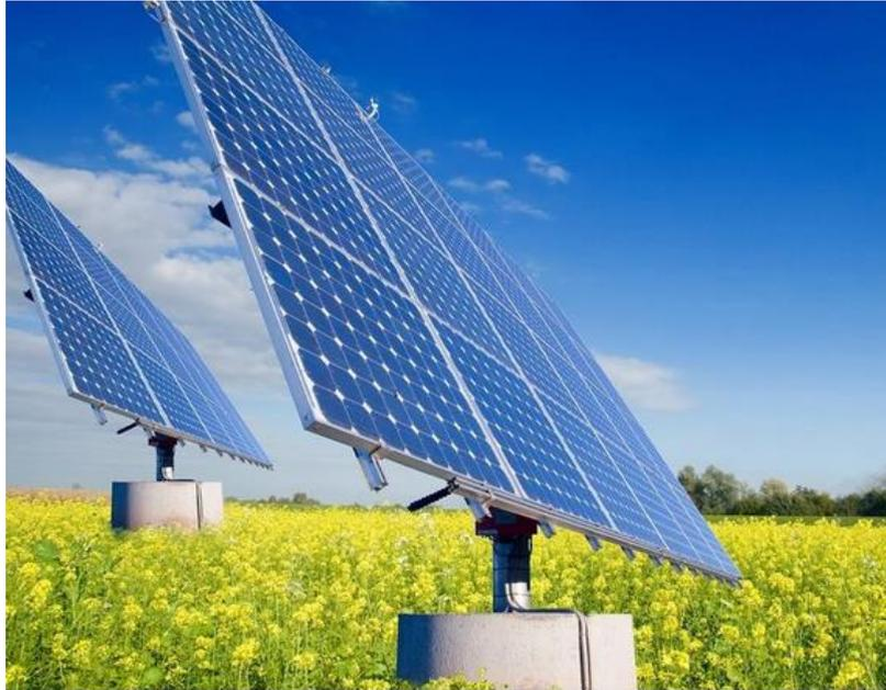
Abbildung 13: Darstellung von zwei nachgeführten PV-Systemen
