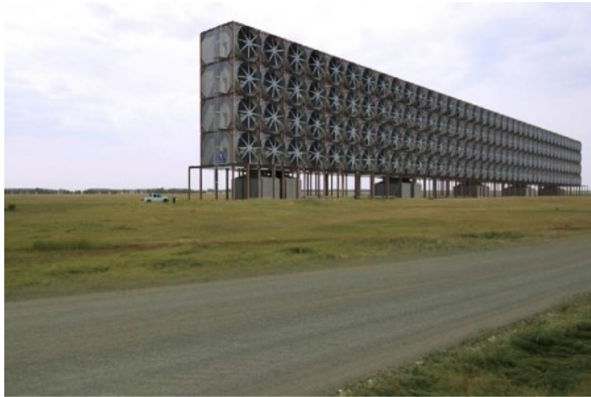
Abbildung 16: Konzeptzeichnung des CE-Luftkontaktors [95]
