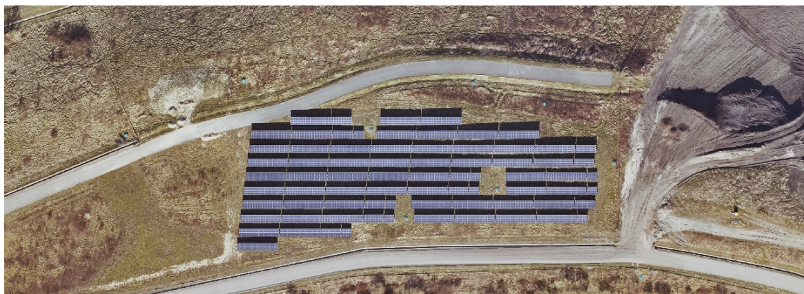
Abbildung 3.2: Die Photovoltaikanlage aus der Vogelperspektive (Quelle: [18])
