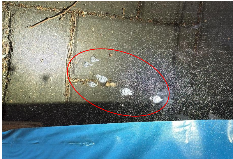
Abbildung 10: Einschlaglöcher durch den Dorn des Halligan-Tools (Eigene Darstellung)
