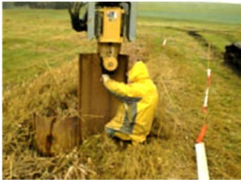
Abbildung 47: Einbau einer Metallspundwand (LfU 2010)
