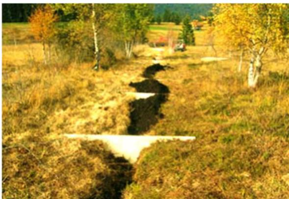
Abbildung 43: Mit Torf gefüllter Graben vor dem Abdecken mit Holzplatten-Sperren (Lugon u. a. 2009)
