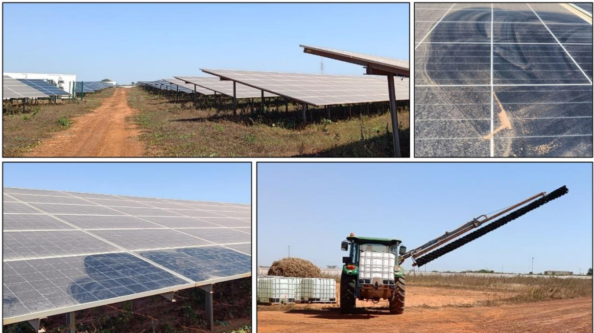
Abbildung 1.1 Fotos des Solarparks in Diass, saubere und verstaubte Solarmodulen, Traktor mit Reinigungsbürste
