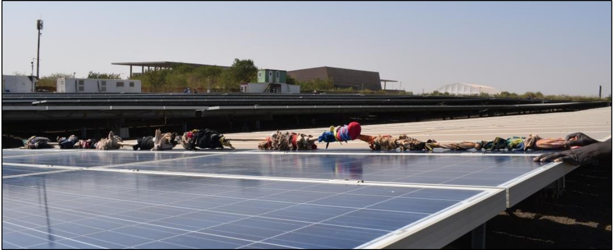
Abbildung 1.2 Solarpanelreinigung im Solarpark Diamniadio mit Textilstücken
