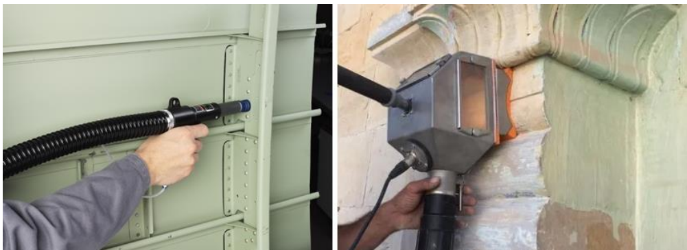
Abbildung 4: (links) Entschichten von Metall-Nietköpfen; (rechts) Reinigen von Naturstein mittels Vakuumsaugstrahlens [11]
