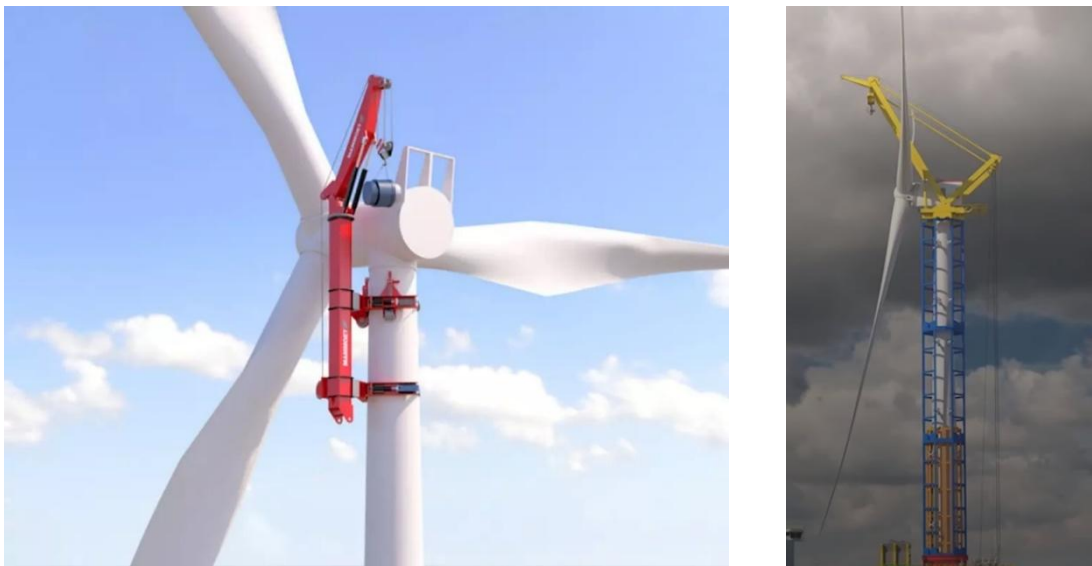
Abbildung 9: Krankonzepte am Turm der WEA: Kletterkran (links) [37]; selbsterrichteter Kran (rechts) [38]
