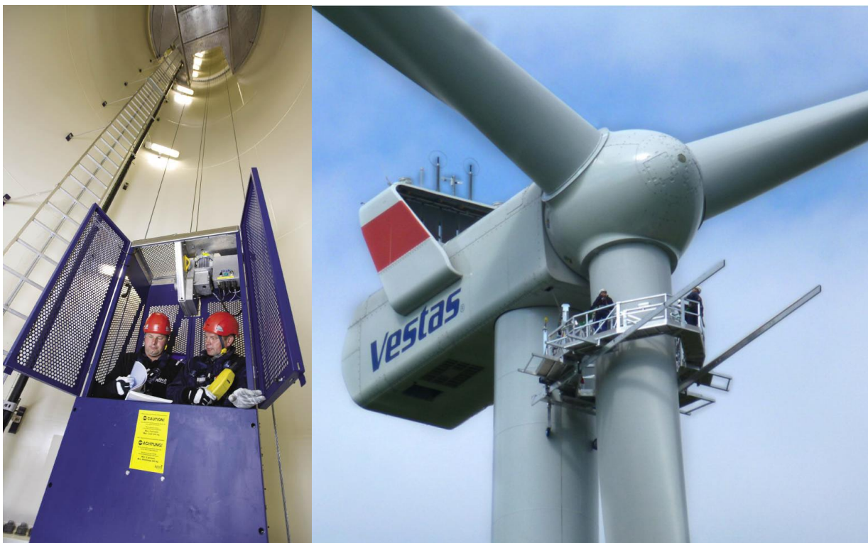
Abbildung 7: Wartungslift innerhalb einer ERWEA (links) [30]; Rotorblattwartungslift (rechts) [33]
