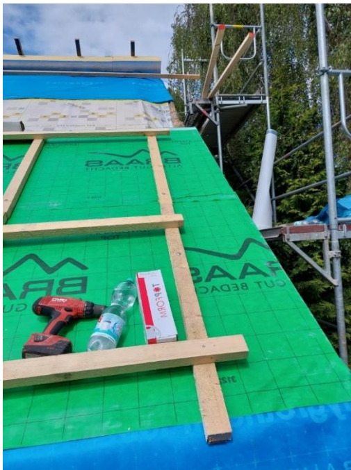
Aufbringen der Aufsparrendämmung
