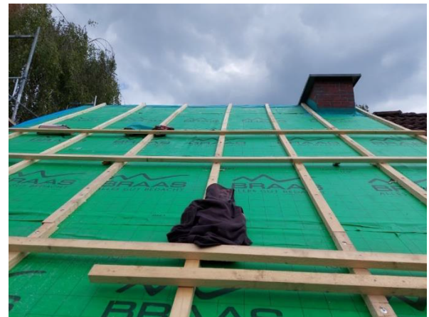
Aufbringen der Aufsparrendämmung
