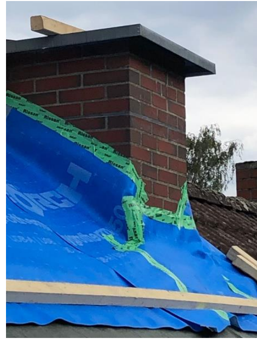
Aufbringen der Aufsparrendämmung
