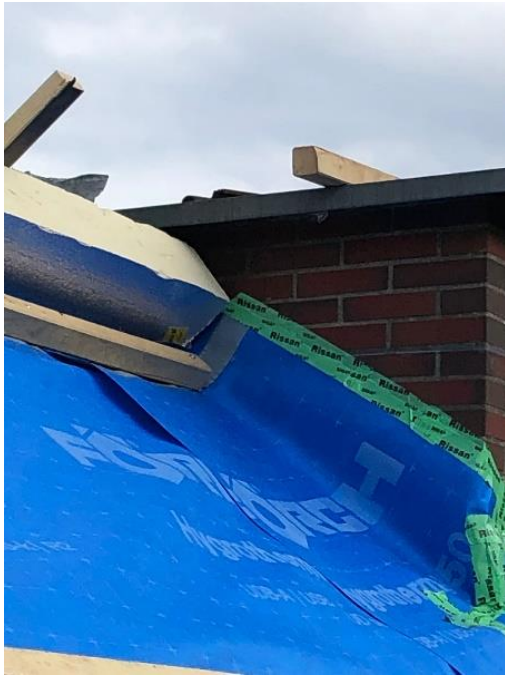
Aufbringen der Aufsparrendämmung
