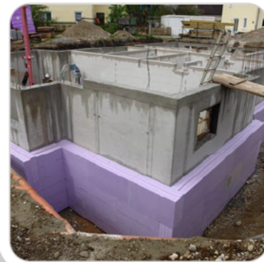
Perimeterdämmung
