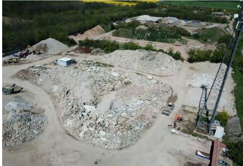
Abbildung 1: Recyclinghof Heinz Werner GmbH Aschara. Angelieferter Betonbruch im Vordergrund (Quelle: Denny Silabetzschky, zur Verfügung gestellt)
