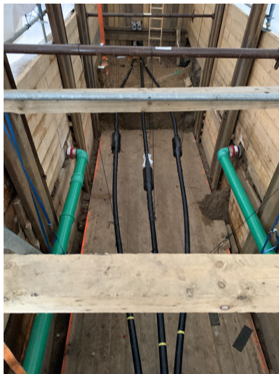
Abbildung 2.4: Muffengrube eines Leiters
