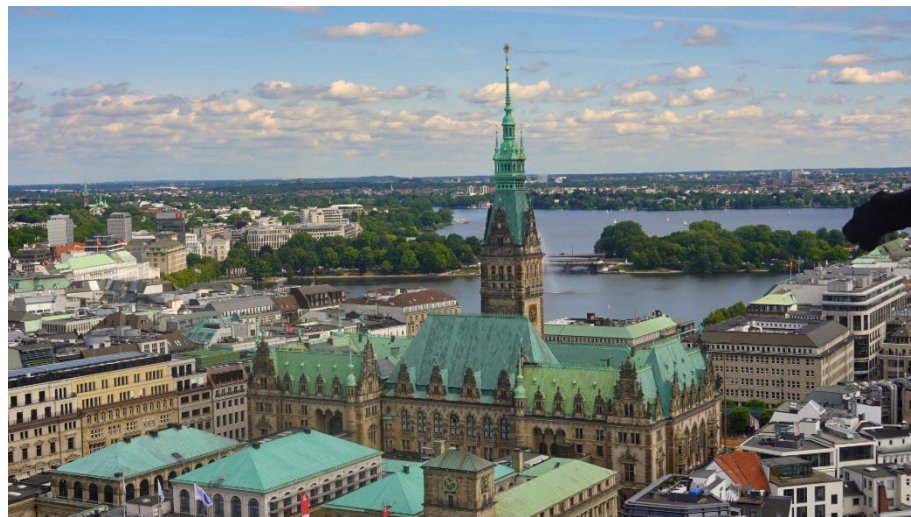
Abb. 50 Kupferdächer wurden auch zu Teilen des Uhrenturms
