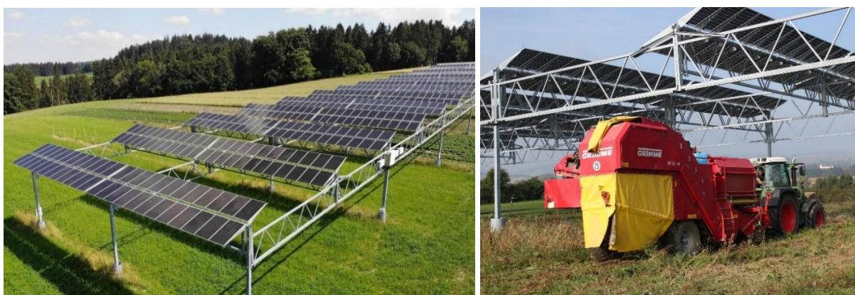
Abbildung 2: Hochaufgeständerte Agri-PV-Anlage in Heggelbach (Fraunhofer ISE, 2024a; BayWa r.e. AG, 2025)
