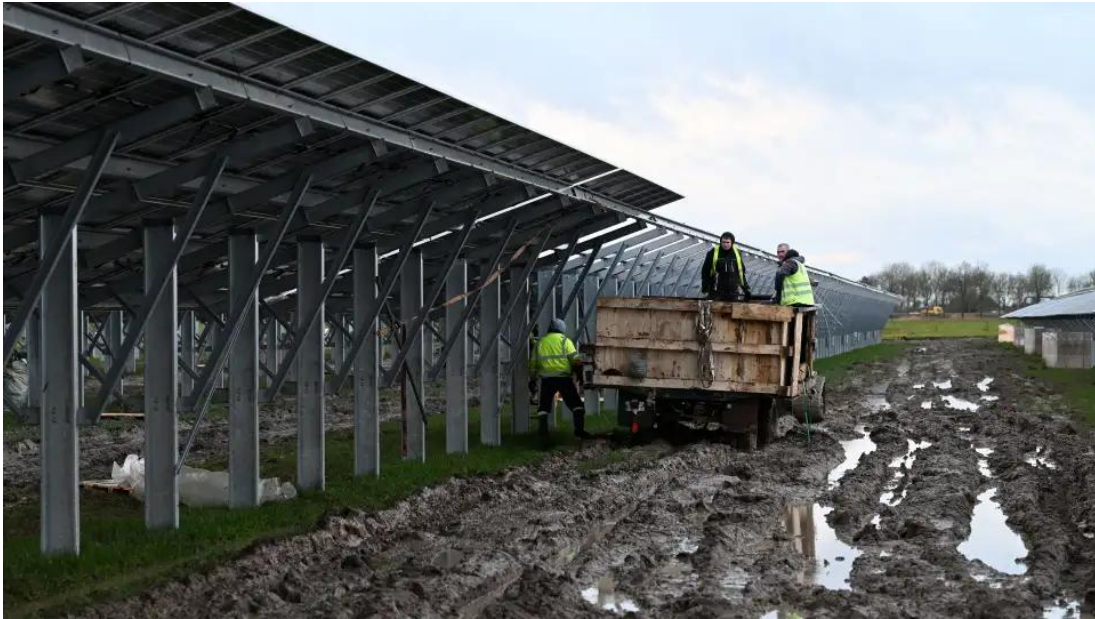
Abbildung 4: Installation der Agri-PV-Module in Lemwerder (Wenke, 2025)
