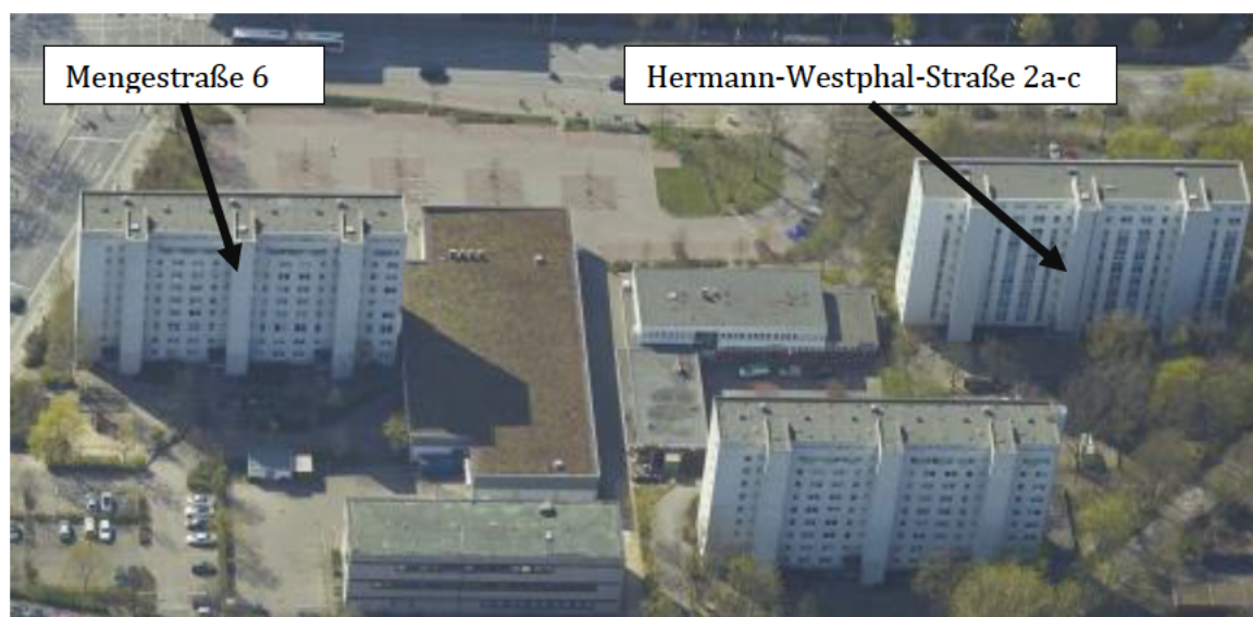
Abbildung 58: Luftbild der Gebäude Mengestraße 6 (links) und Hermann-Westphal-Straße 2a-c (rechts) [25].
