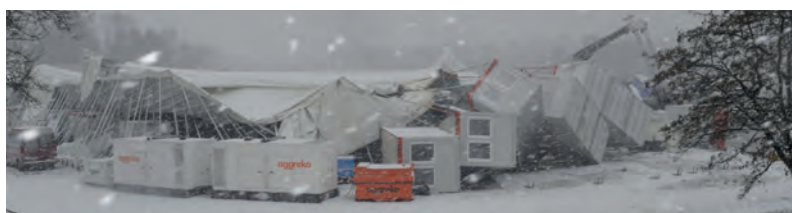
Abb. 47: Das Veranstaltungszelt am nächsten Tag. Trotz Maßnahmen der Feuerwehr in der Nacht, konnte ein Einsturz nicht verhindert werden. Die Kraft des Windes war so groß, dass sogar Baucontainer umgeworfen worden sind.
