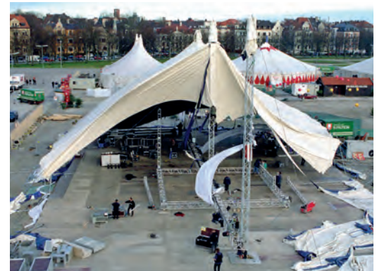
Abb. 13: Zelteinsturz nach Sturmböen
