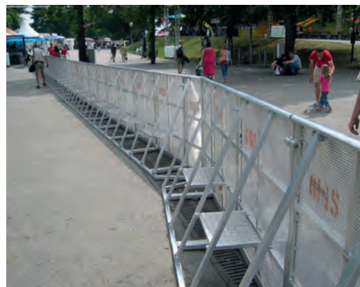
Abb. 14: Absperrung innerhalb eines Stehplatzbereiches – Rückansicht
