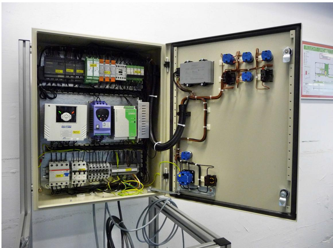
Abbildung 5.2: Schaltkasten des neu entwickelten Motorenprüfstandes
