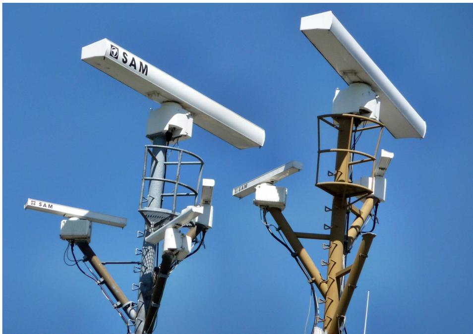
Abbildung 1.1: S-Bandradaranlage (große Antennen) und X-Bandradaranlage (kleine Antennen)
