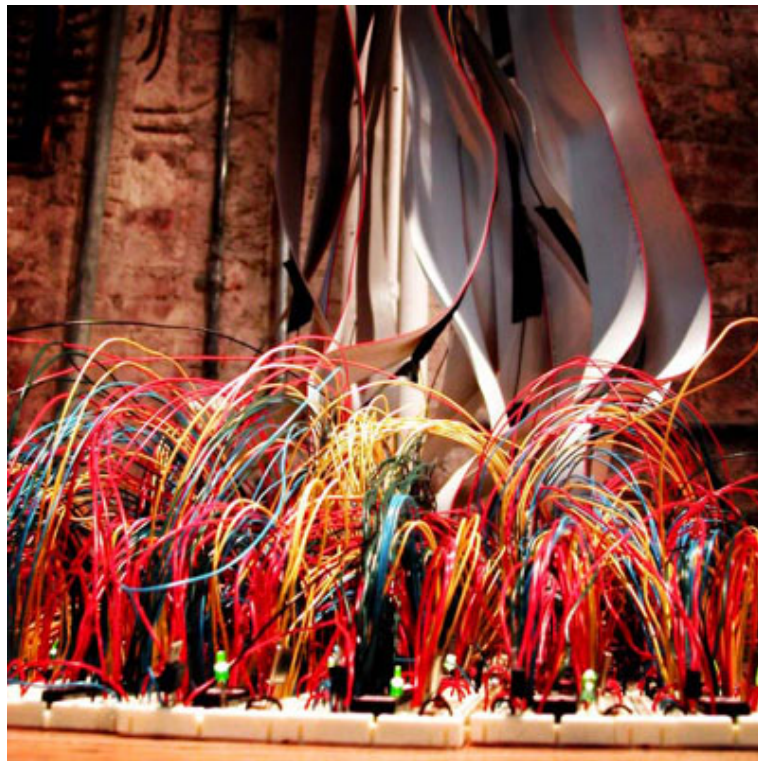
Abbildung 2.3: Detailansicht des Controllers, aufgebaut auf Breadboards
