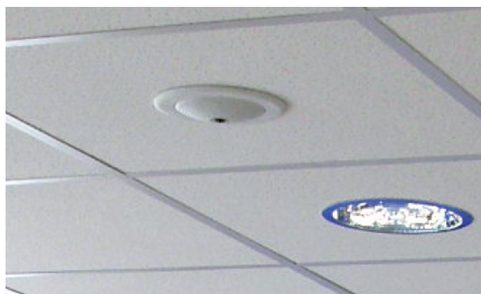
Abbildung 4.6.: Deckenmontage einer hemisphärischen Kamera aus Mobotix (2009)
