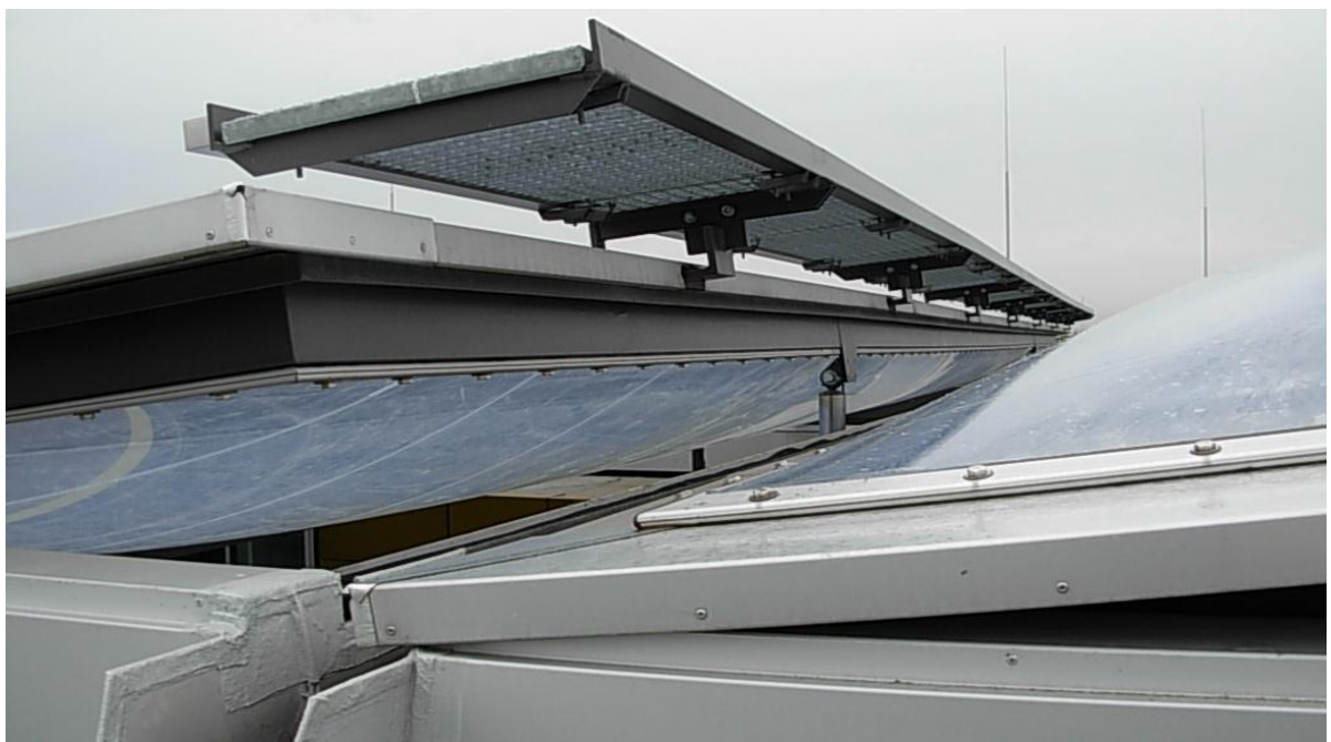
Abb. 9: Folien-Schweißnähte, Öffnungsmechanismus, Entwässerung und Begehung MTZ
