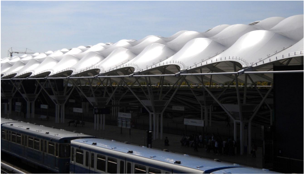
Abb. 6: Membrandach aus PTFE-beschichtetem Glasfasergewebe U-Bf. Fröttmaning in München
