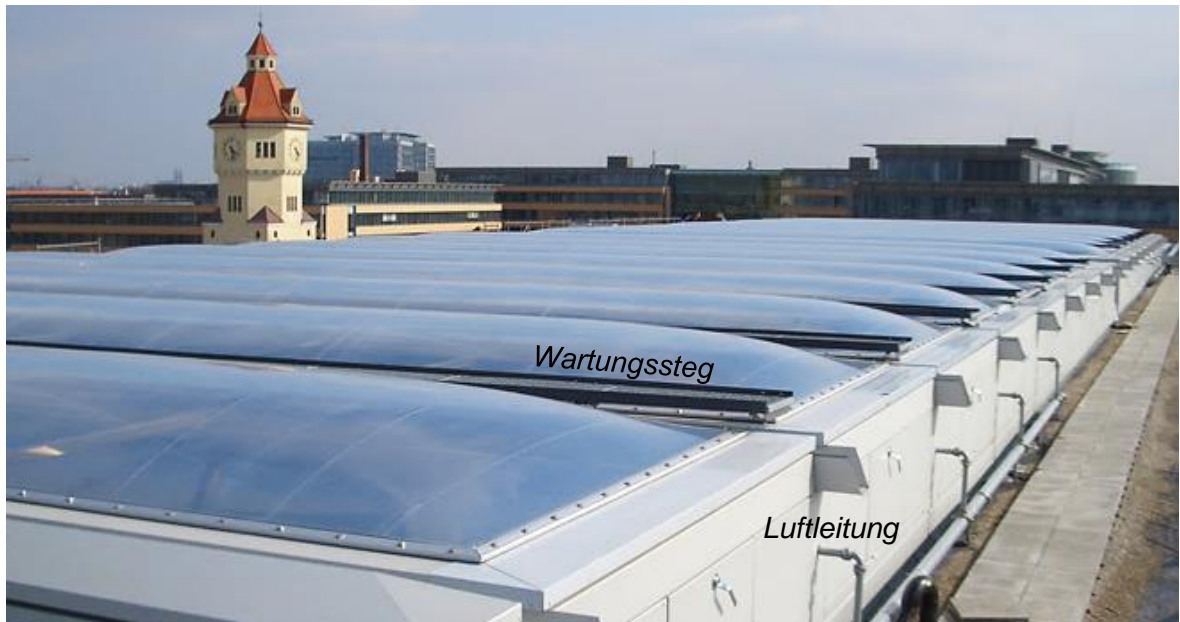
Abb. 8: Membrandach aus ETFE-Pneus >> MTZ (Stadtwerke München)
