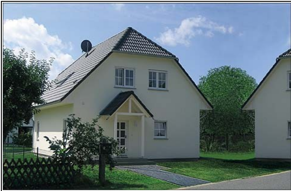
Abbildung 20: Haus: Außenansicht [PRO2010]
