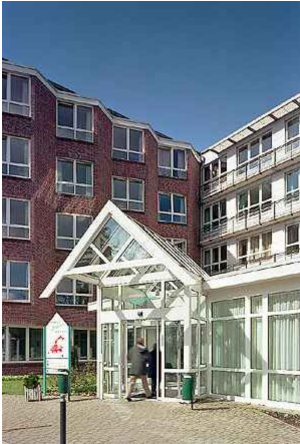
Abb.8: Eingangsbereich Elbeklinikum Buxtehude
