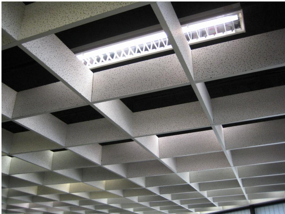
Abbildung 61 Anordnung der Beleuchtung im Großraumbüro
