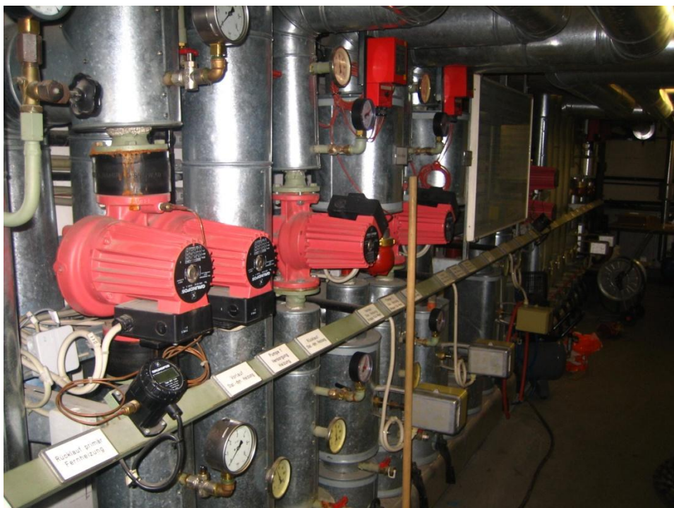
Abbildung 72 Heizungsanlage Pumpensystem
