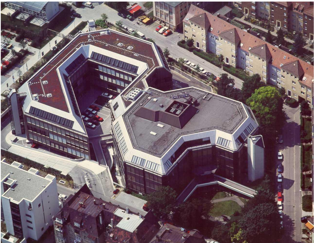
Luftaufnahme des Bürogebäudes der Firma FICHTNER GmbH & Co KG
