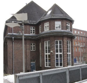
Abbildung 1.4: Living Place Hamburg, Außenansicht. Quelle: [HAW Hamburg]
